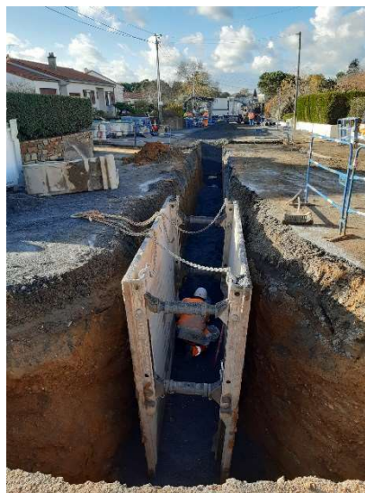
Travaux de requalification des réseaux EU / EP / AEP sur le quartier du fief des pommiers
